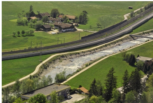
Wörgl-Bruckhäusl, Baulos 1, Lärmschutzwände entlang der neuen Trasse
